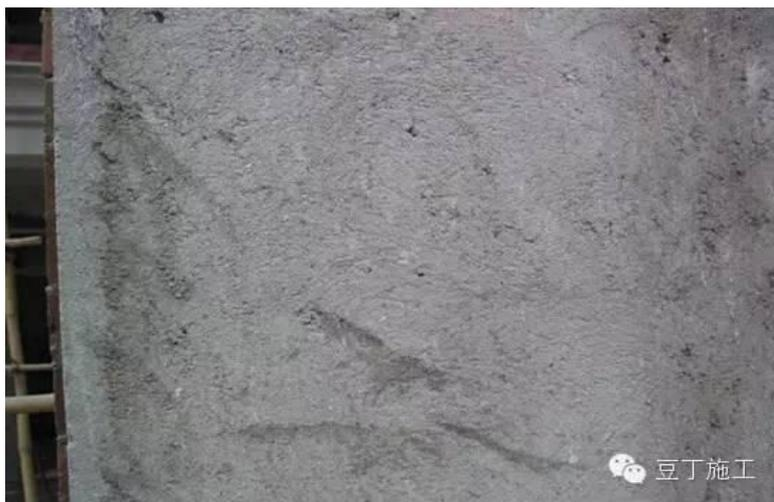
普通水泥砂浆和易性与粘连性差，施工开放时间短，施工主要以提高灰砂比使砂浆在短时间内固结的做法应对。这不但使得抹灰层的硬脆性极为明显，而且施工也难于将抹灰层搓压密实，是这类墙面之所以普遍存在网状裂缝与空鼓的主要缘故。
