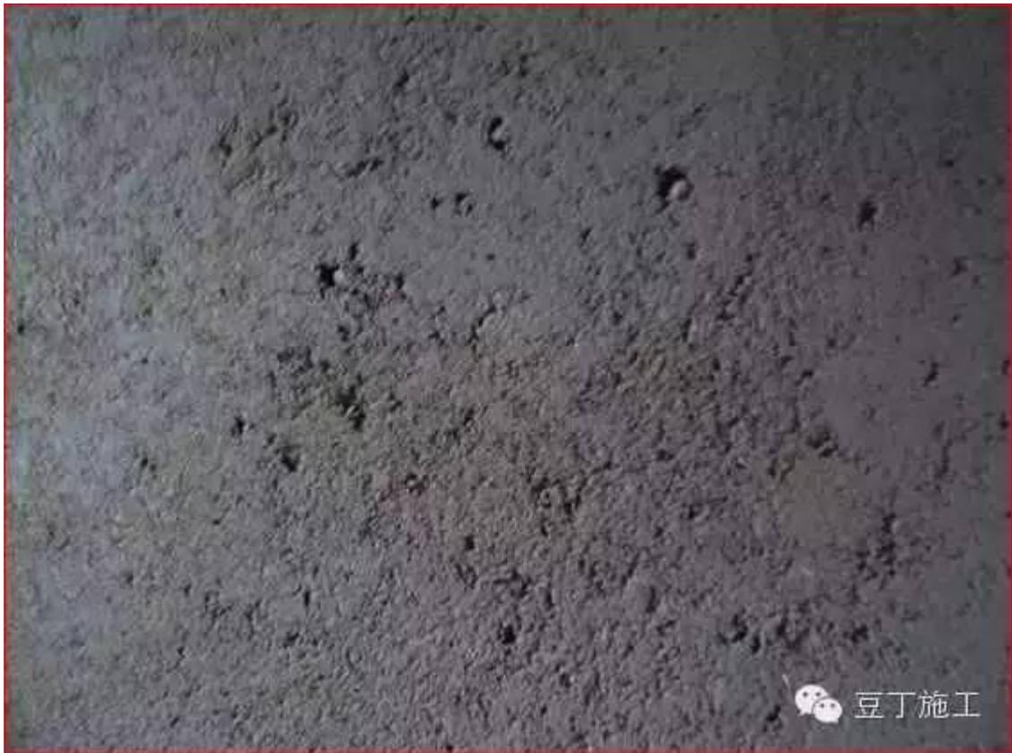
砂浆中难免会存在较粗骨料或异物，施工就无法将浆料搓压或挤压密实了。
