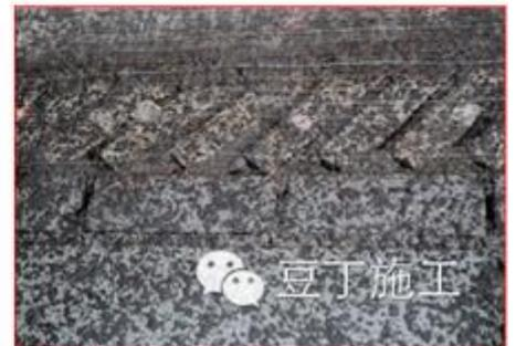
抹灰之前没有对基层上的凹凸不平及孔洞部位作出修补处理，以及抹灰层收口界面粗糙，施工就难以将砂浆料搓压密实。
