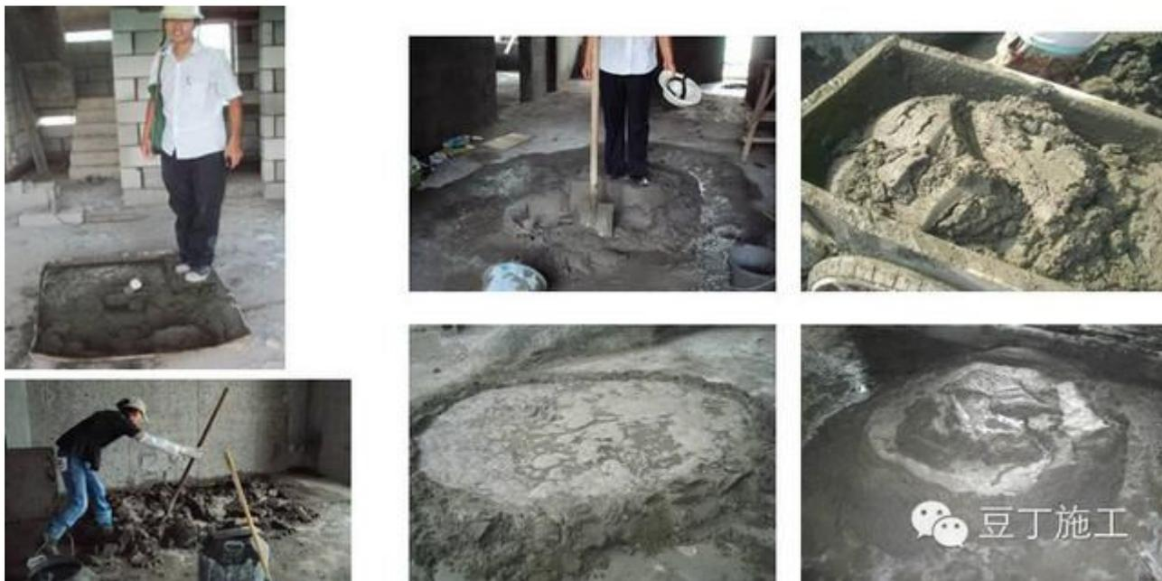
新拌砂浆超过施工开放时间或受到污染，必然大大大降低砂浆的施工操作性和粘结力。
