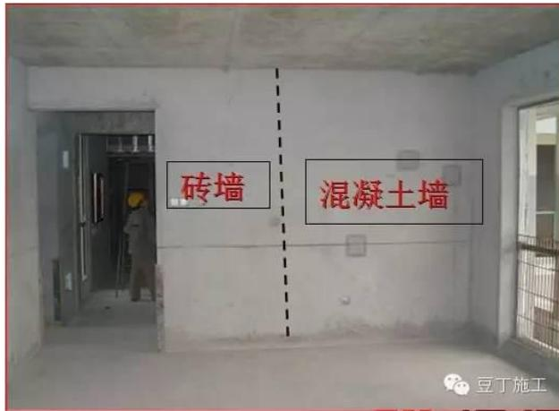
一则，砌体与混凝土结构的抹灰层基面，在饥水性方面存在着较大的差异，抹上墙的砂浆其初凝时间是无法一致的。
